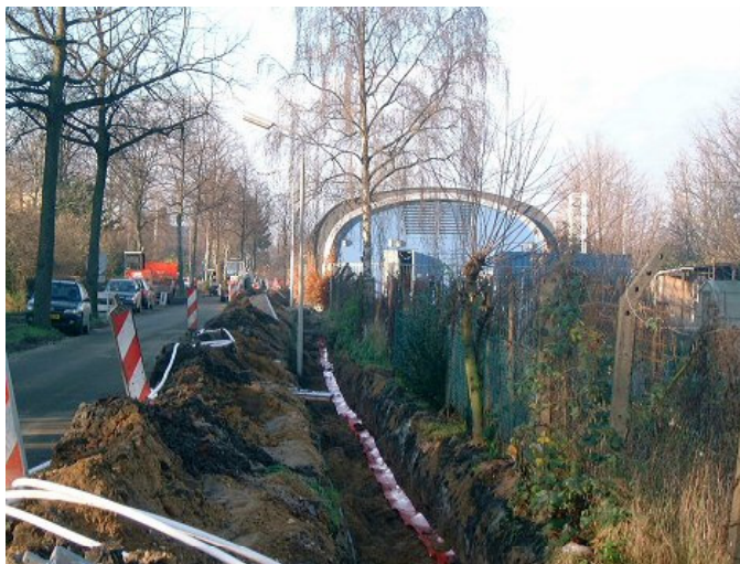
Figuur 2 Aanleg van glasvezelbuizen langs de campus van de Radboud Universiteit in Nijmegen in 2002
