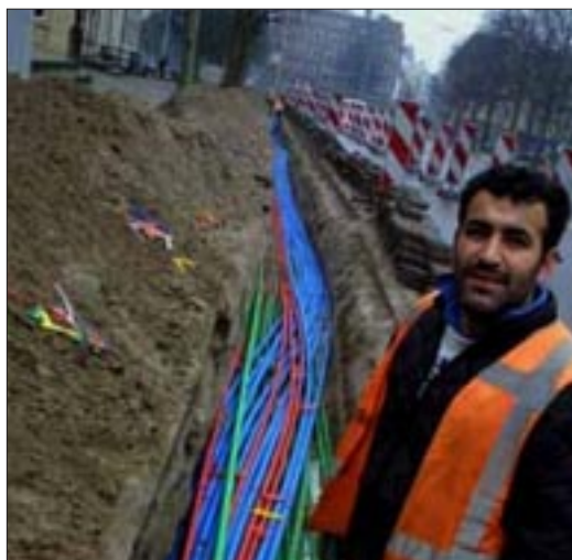
Foto 3. De aanleg van glasvezelkabels voor telecommunicatie, ergens in Den Haag (bron: NRC Handelsblad, Leo van Velzen).
